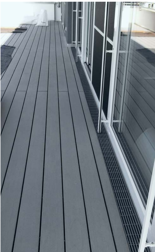
Střešní byt, Wiehl, Německo
