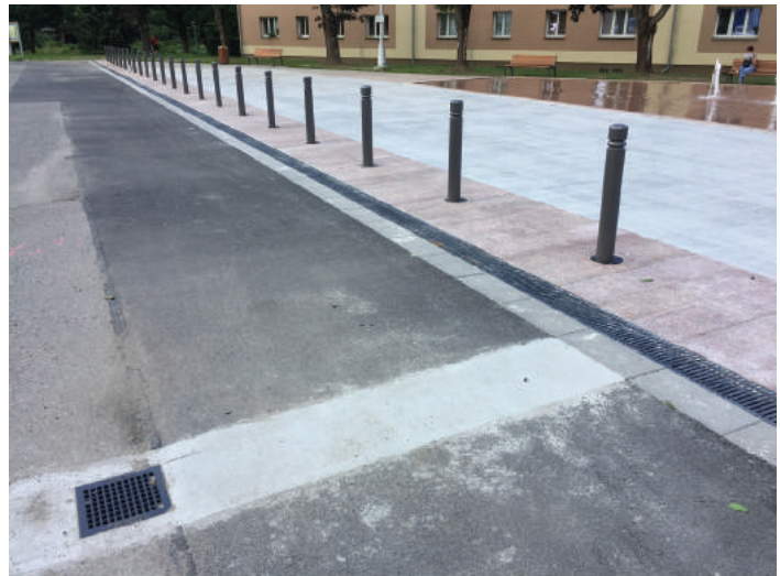
Rekonstrukce Radničního náměstí, Vratimov
