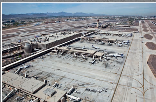
Beton je neprodyšný materiál a proto se často používá v současné dopravní infrastruktuře (vozovky, letiště, vodohospodářsky důležité stavby a místa manipulace s nebezpečnými odpady).
