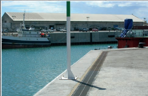
Použití v korozivním prostředí u moře.
