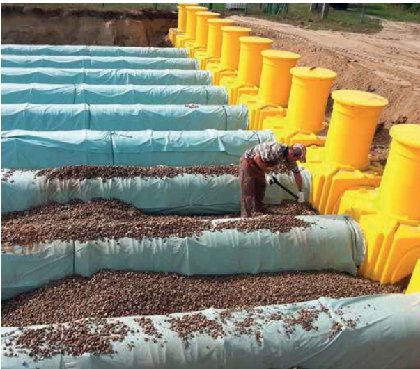
Vsaky dešťové vody, Gryzliny, PL
